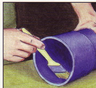
A Köratac HF 300 ragasztóanyagot hosszanti irányba vigyük fel
